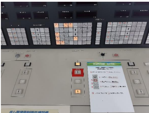
ダム管理用制御処理設備
